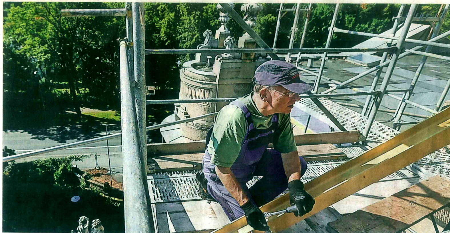
Diethelm Schmidt vom Stahl- und Metallbau Weiner aus Ludwigsdorf an seinem Arbeitsplatz an der Stadthalle: Er montiert die Ersatzpfeiler, die das Gebäude während der künftigen Arbeiten stabilisieren sollen.
